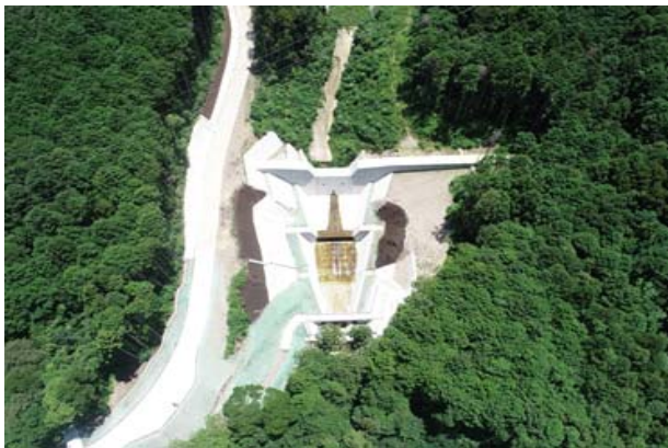
石合川火山砂防工事 (1号えん提工)
