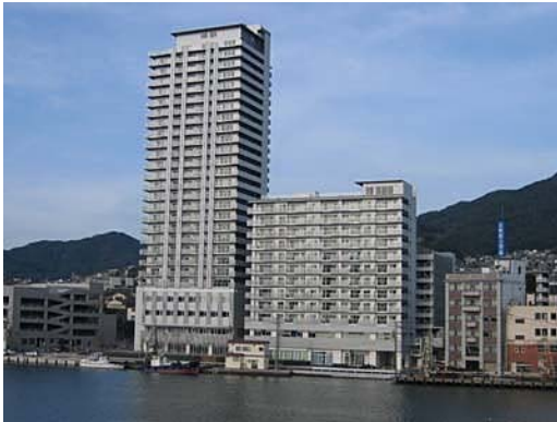
タワーシティ長崎新築工事
