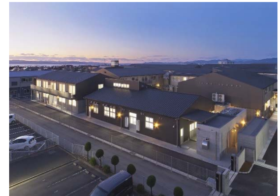
ろう学校移転改築寄 宿舎棟建設工事
