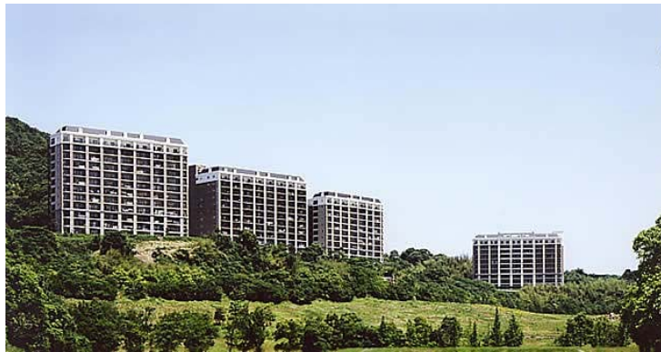
ハウステンボスヒルズ新築工事
