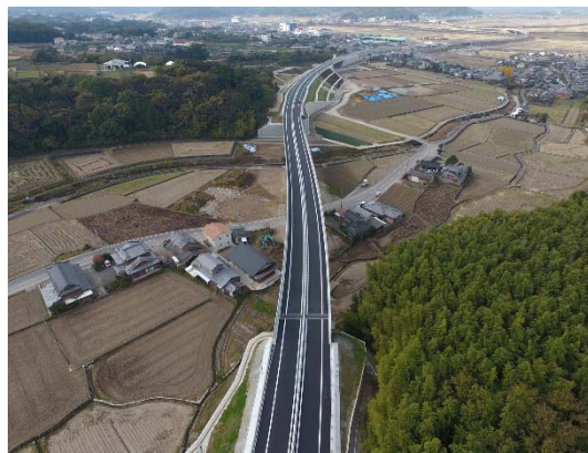
国道251号橋梁整備工事
