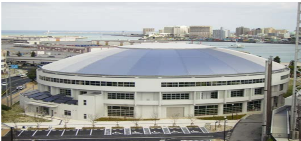
那覇市宮奥武山野球場 (多目的屋内運動場)
